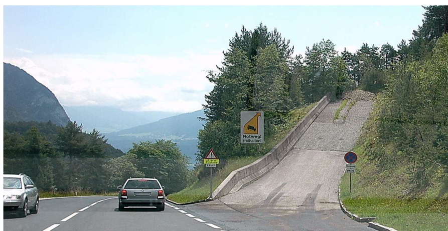
Рисунок 2 — Приклад улаштування уловлювального з'їзду
