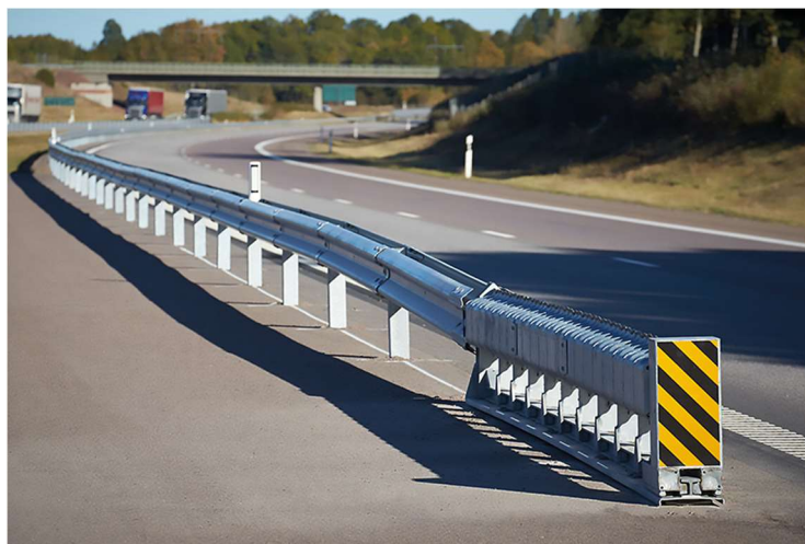
Рисунок 5 — Приклад застосування амортизаційного пристрою перед двобічною бар'єрною огорожею
